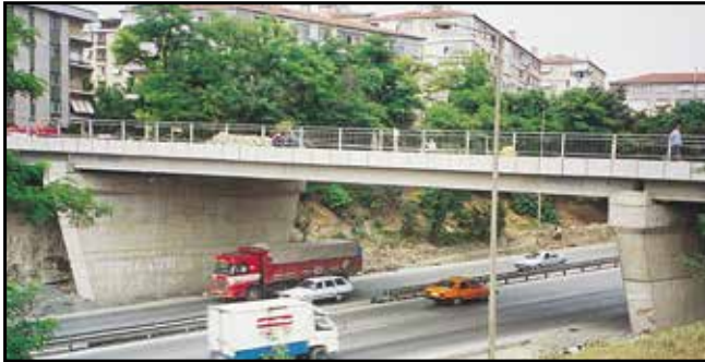
İstanbul Kūçūkçekmece-Cennet Mahallesi E-5 Araç Őst Geçiti İnřaati (1997-1998)
