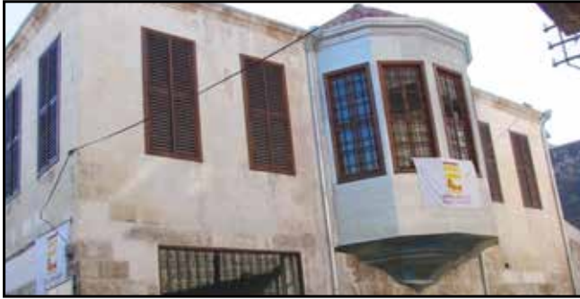
Gaziantep Göğüş Konağı Restorasyonu (2006-2007)
