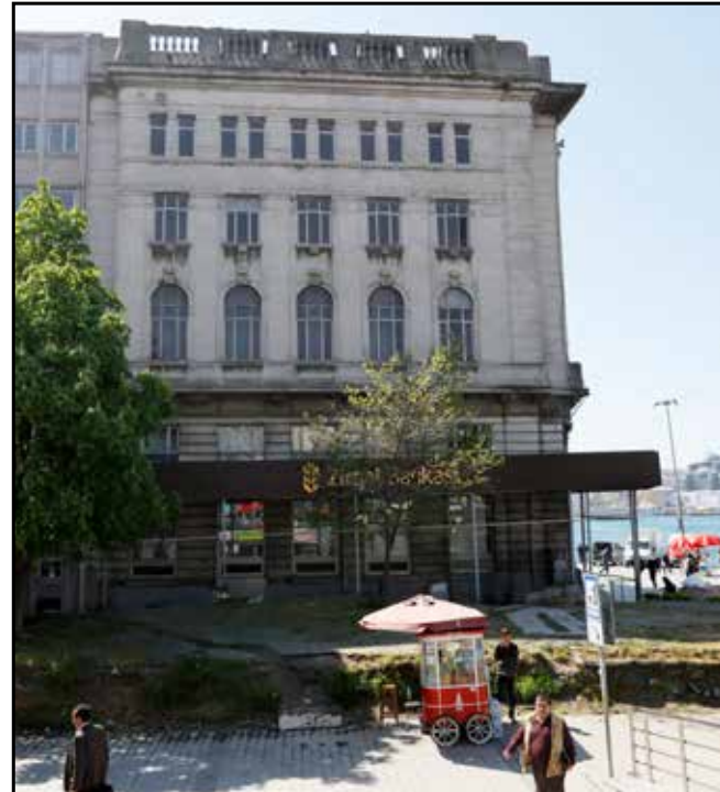
Ziraat Bankası Karaköy Restorasyonu (2017)
