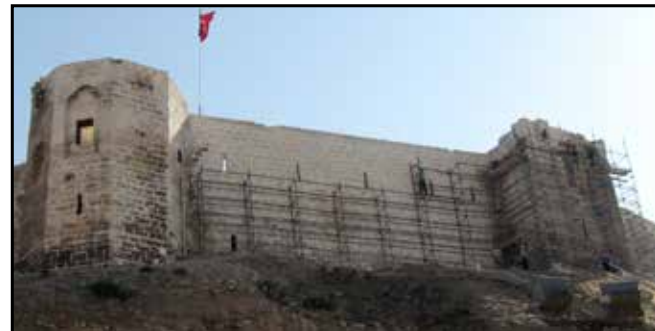
Gaziantep Kalesi Restorasyonu (2008)
