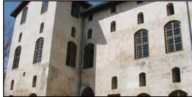
Gaziantep Fatih Sultan Mehmet İlköğretim Okulu Restorasyonu (2006-2007)
