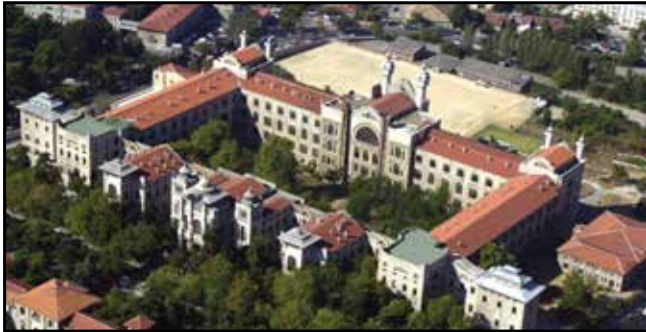
Eski Haydarpaşa Lisesi Çatı Onarımı (2002)
