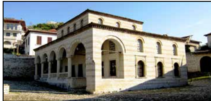
Berat Hünkâr Camii ve Halveti Tekkesi Restorasyon Uygulama İşİ, Arnavutluk Cumhuriyeti (2018)
