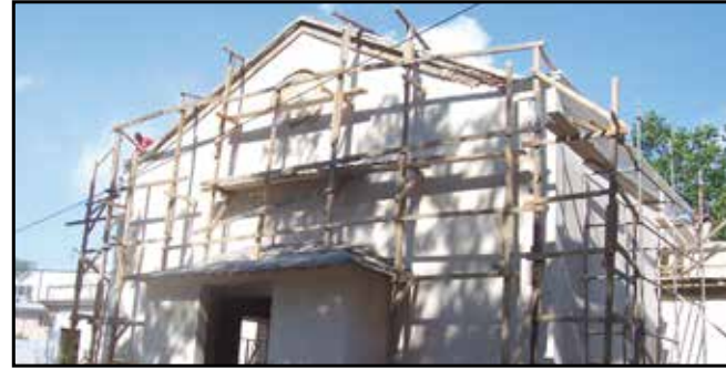
Cendere Hamidiye Su Pompa İstasyonu Restorasyonu (2006)
