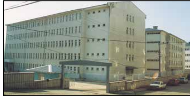
Rize Anadolu Öğretmen Lisesi İnşaatı (2000-2002)
